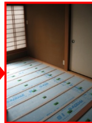
根太の間に断熱材を 敷き詰めます。
