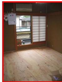
その上に、2枚目の ラッチ合板を敷き ビス留めします。
