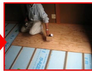
12mm厚のラッチ合板を 敷き、ビス留めします。
