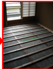
高さを合わせるため 根太を敷き、 ビス留めします。
